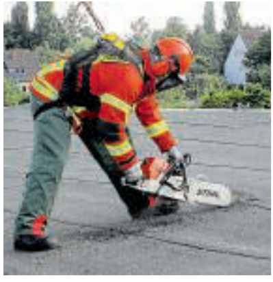
Ein Feuerwehrmann öffnet die Dachhaut mit einer Kettensäge.
